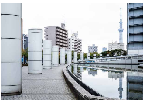
リニューアル前の景観：時代に合わない巨大な照明オブジェ、仕上げグレードの低い水盤、均質的で老朽化した舗装
