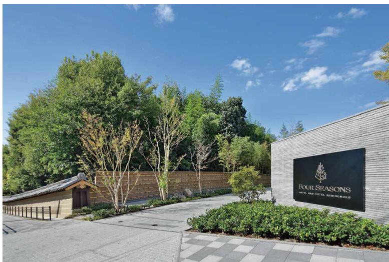
エントランスゲート
