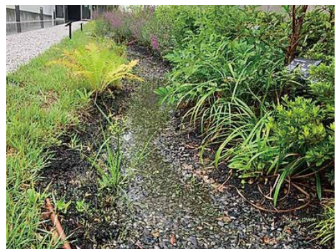
降雨时可以看到雨庭中雨水临时储存的情况
