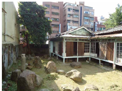
再生计划施工前的石景与建筑
