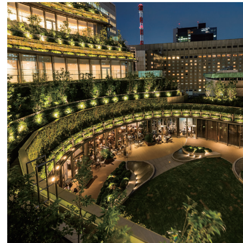
階段状に連続する屋上庭園・壁面緑化
