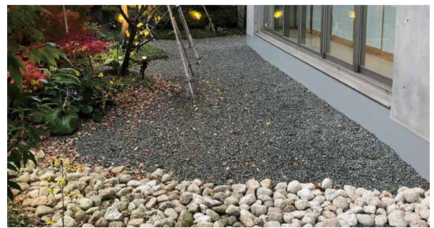
栗石を使用した砂利側溝
