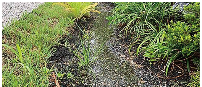
降雨時の雨の一時貯留を視覚化する雨庭
