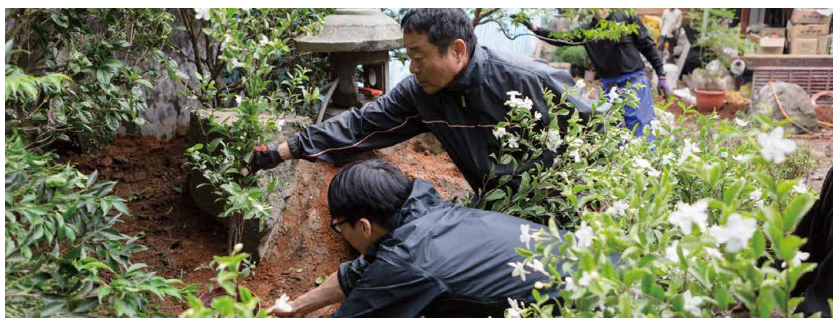
日本と台湾が一体となった施工技術指導
