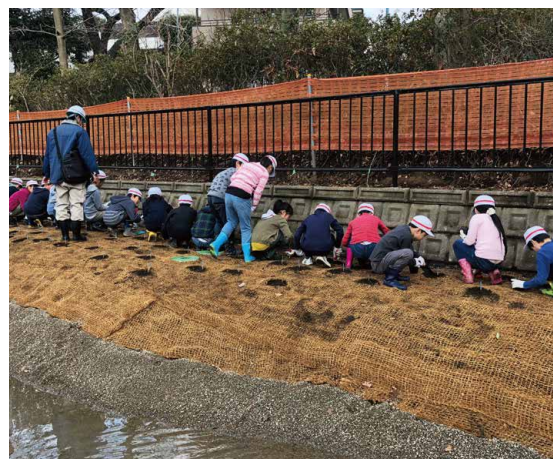
小学生栽种种苗讲习班（正在施工）
